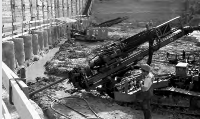
Herstellung der ersten Ankerlage im Bereich der Bohrpfahlwand
